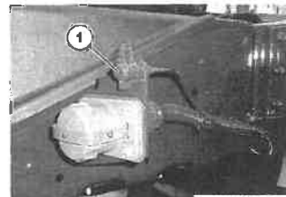
Prüfanschluss neben Batteriekasten
